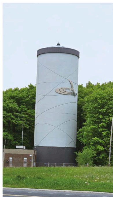
Station de pompage et réservoir d'eau sur le boulevard Lionel-Boulet à Varennes, en bordure de l'autoroute 30. (Photo : GO)
